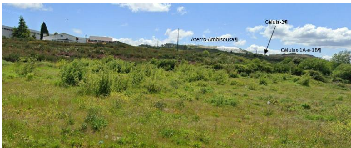
Figura 5.3 - Vista para a área do projeto e do Aterro da Ambisousa, a partir da EM562.
