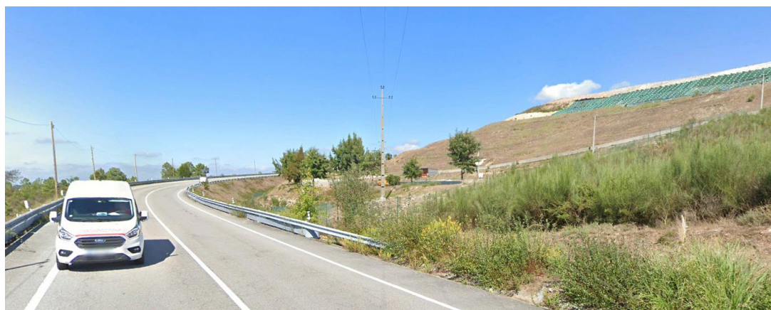
Figura 4.58 – Variante à Serra de Campelos (troço final, adjacente ao Aterro da RIMA).
