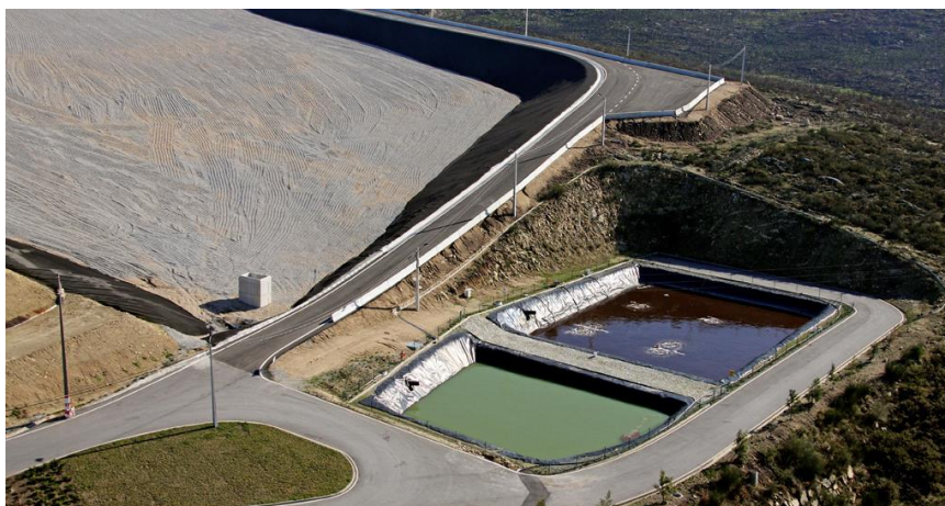
Figura 3.4 –Bacias de retenção (pluviais à esquerda e lixiviados à direita).
